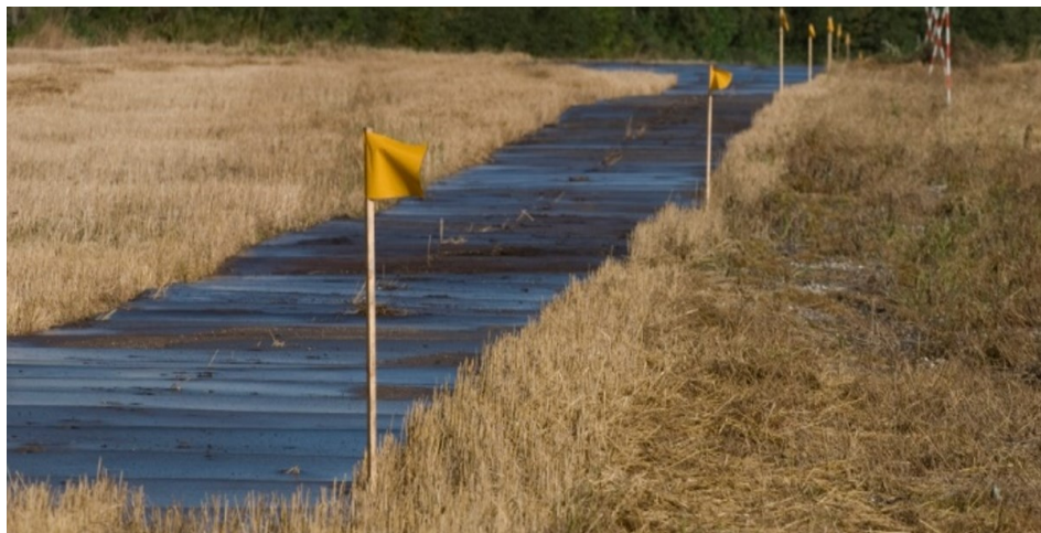
Figur 4.12 adgangsvej med køreplader.
