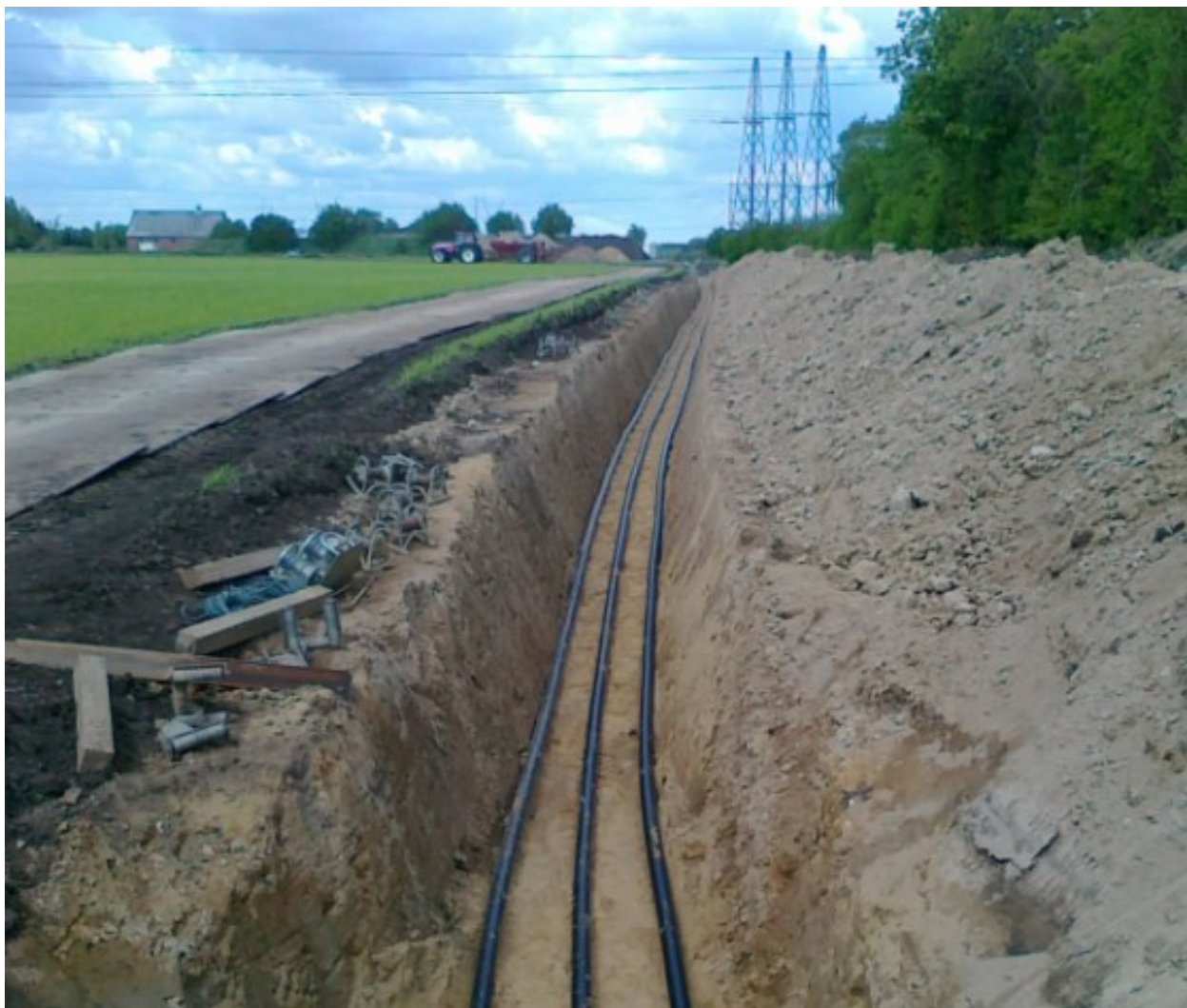
Figur 4.5. Kabelanlæg lagt ud i åben grav.
