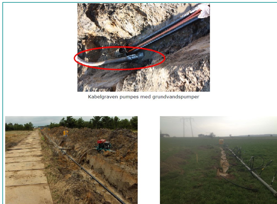
Figur 4.10. Forskellige metoder til at holde kabelgraven tør. På billedet til venstre etableres drænrør, til højre etableres sugespidsanlæg
