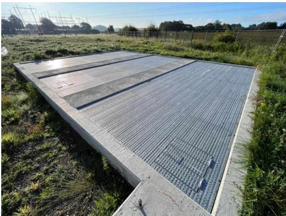
Figur 3.3. Fundament/kar som det ser ud inden reaktor placeres ovenpå.
