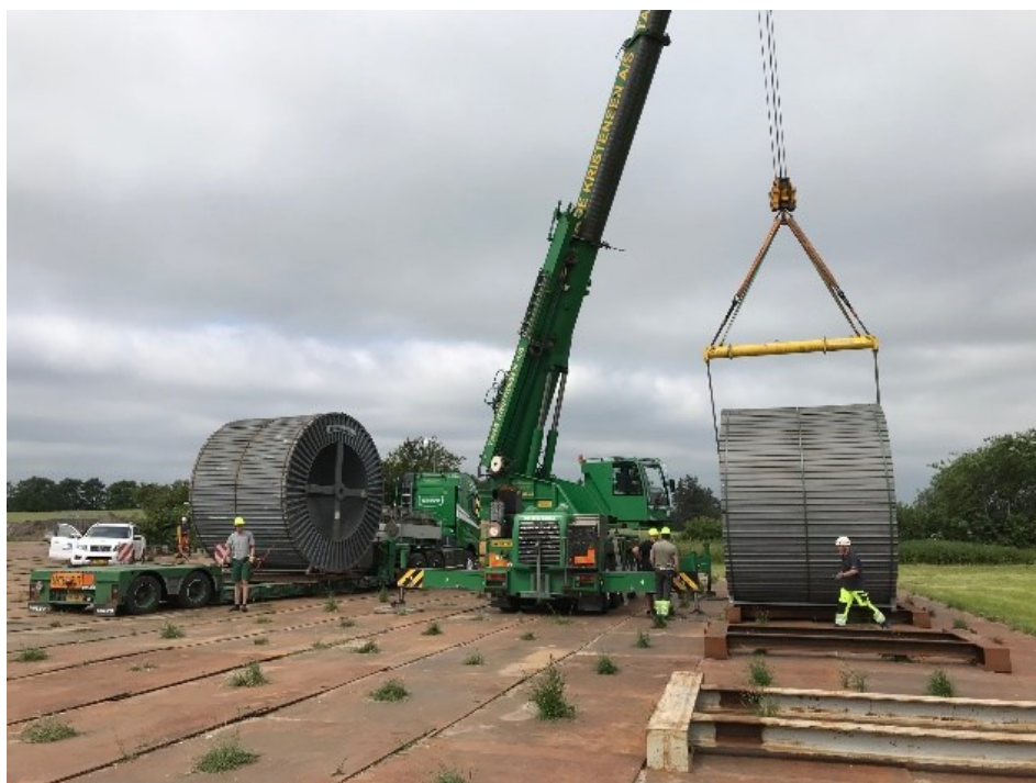
Figur 4.11. Håndtering af kabeltromler på tromleplads.
