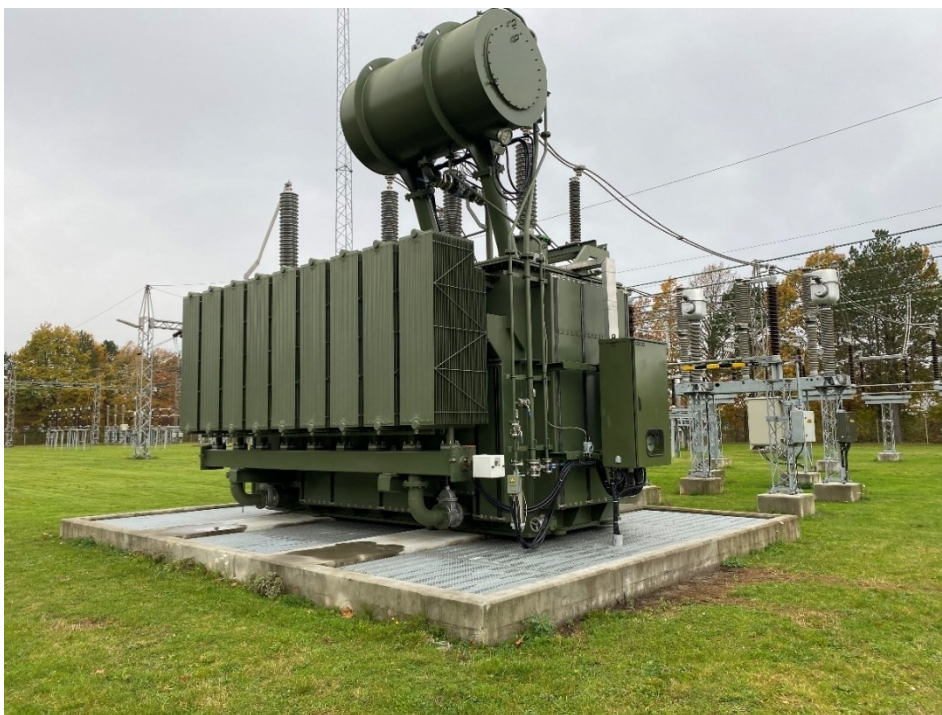
Figur 3.4. Eksempelfoto af 132 kV reaktor.
